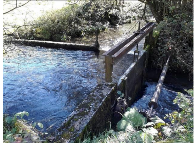
Schieber bei Gütsch (im Vordergrund)
